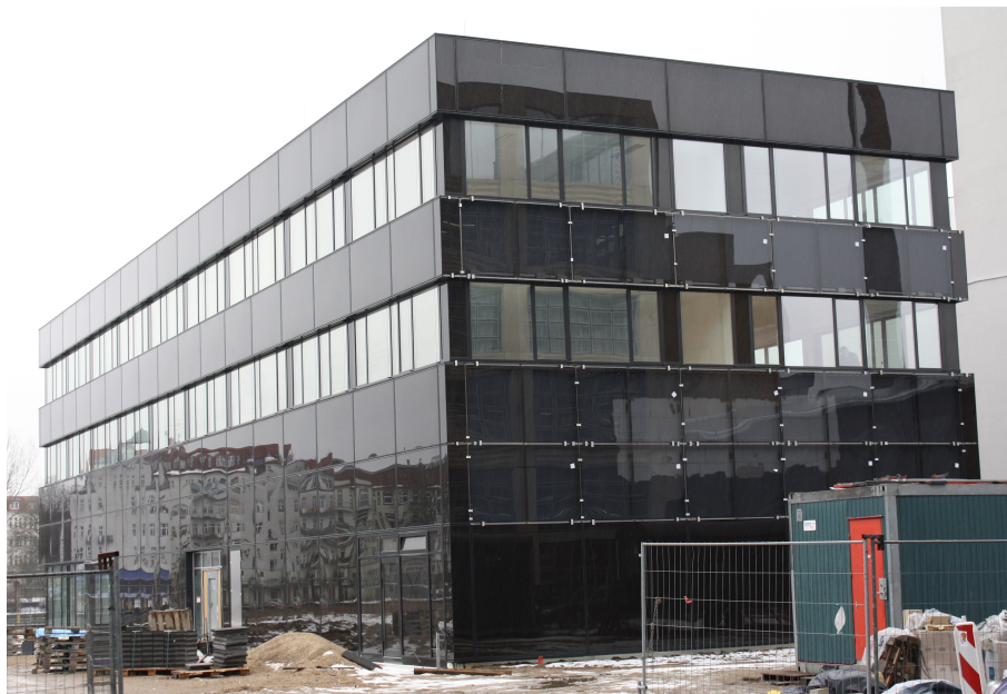
Abbildung 3.3: Foto des FKI-Gebäudes (29.01.2013)
